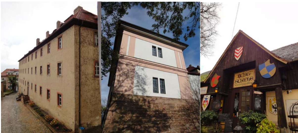
Abbildung 6: Betrachtete Bestandsgebäude auf der Leuchtenburg Logierhaus, Torhaus und Burgschänke (v.l.n.r)
