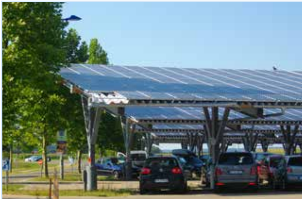
Solare Überdachung in Bad Wörishofen (©Dagmar Everding)
