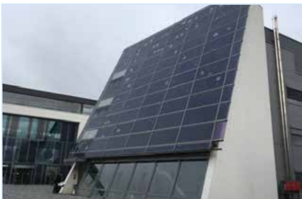
SMA-Gewerbebau in Niestetal (©Dagmar Everding)
