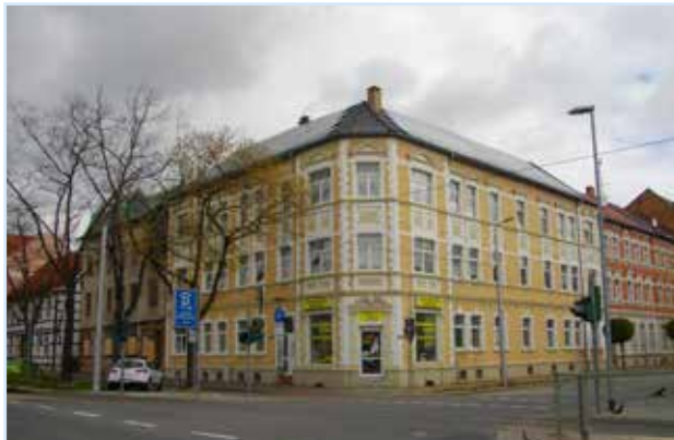
Dach-PV-Anlage in Nordhausen, Grimmelallee (©Dagmar Everding)
