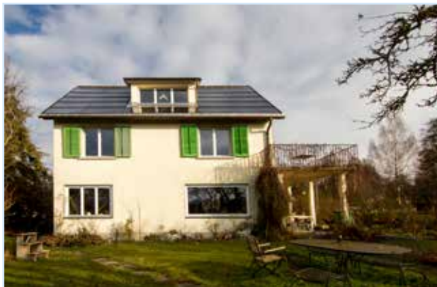
Haus mit Indach-Solaranlage der Fa. Axsun (©AxSun Solar - www.axsun.de )
