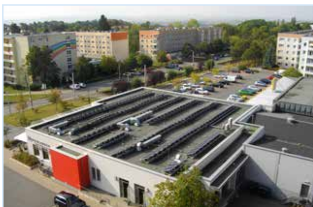
PV auf Flachdach in Nordhausen-Nord (©Dagmar Everding)
