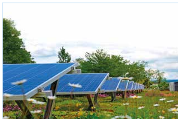
Gründach mit PV der Fa. Bauder (©Bauder GmbH & Co.KG)
