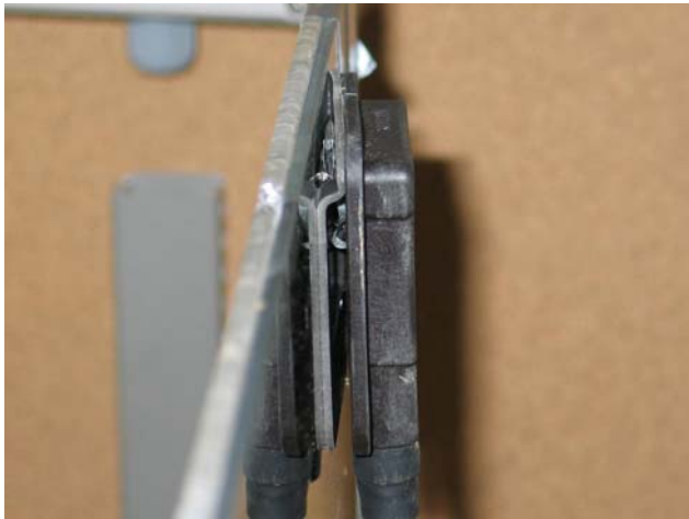
Abbildung 9: Abgelöste Anschlussdose eines Photovoltaikmoduls (Foto: Voswinkel)
