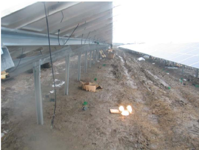
Abbildung 13: Inbetriebnahme einer Photovoltaikanlage Ende 2011 (Foto: Voswinckel)
