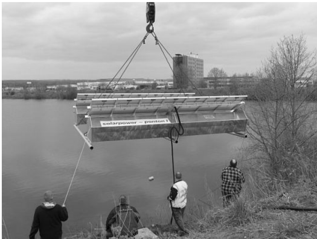
Abbildung 1: Errichtung der Anlage
