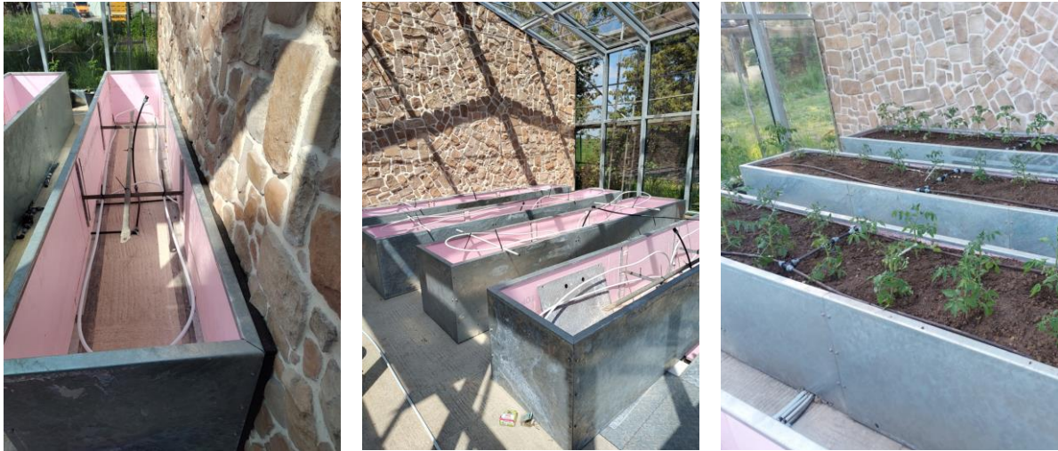
Abb. 21: Aufnahmen aus dem Fertigungsprozess der Hochbeete, links: Installation der erdgebundenen Strahlungsheizung V1, Mitte: Installation der pflanzennahen oberflächigen Strahlungsheizung V2
