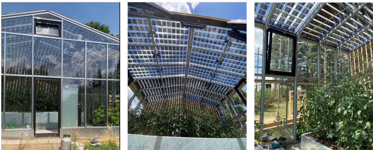
Abb. 22: Solargewächshaus nach Fertigstellung in der Monitoringphase
