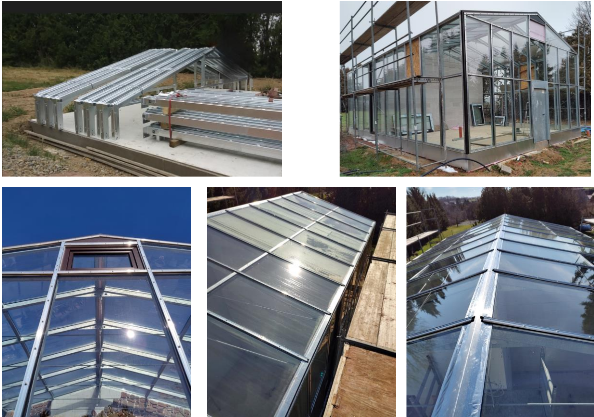
Abb. 19: Aufnahmen aus der Bauphase des Großdemonstrator-Gewächshauses: oben links: Bodenplatte mit Rahmenscheiben und Stützen vor der Montage, oben rechts: fertig montiertes Gewächshaus, unten: Dachkonstruktion mit Doppelverglasung ohne PVT-Module
