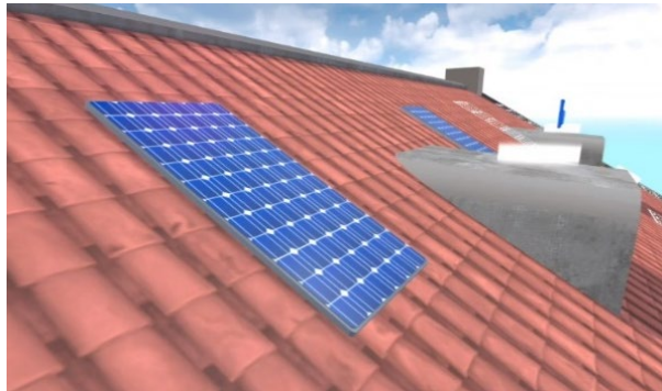
Abbildung 5: Anbringung der PV-Module
