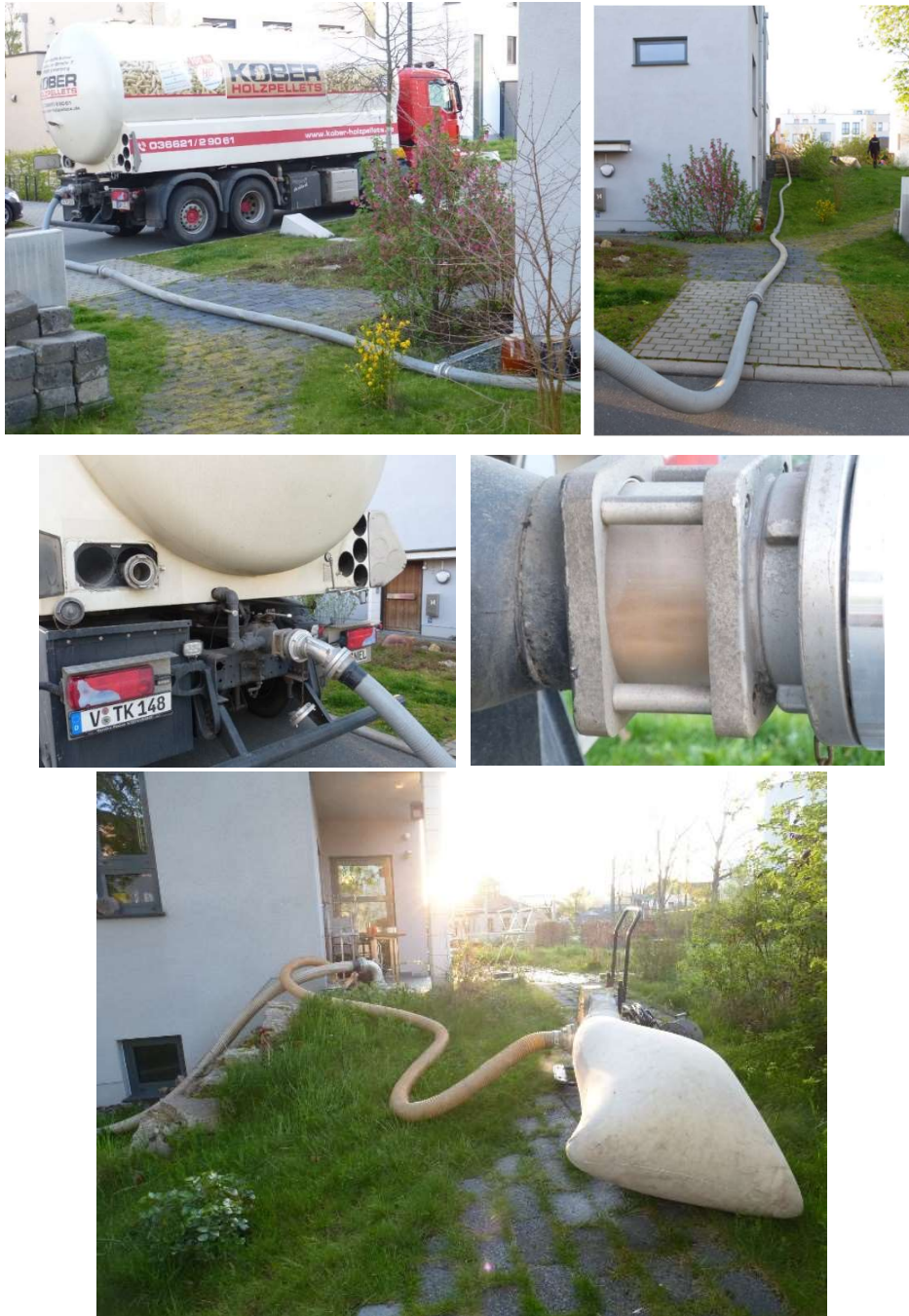
Abb. 2: oben und mittig: Anlieferung der Pellets mittels Lkw und Einblasung in den Speicher über Leitungen; unten: Absaugung und Filterung des Luft-Holzstaub-Gemischs aus dem Speicher (Fotos: Spessert)
