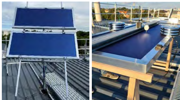
Abb. 5: Im Solarlabor installierte Funktionsdemonstratoren (links) und Rahmen-Belastungs-Verformungs-Prüfung (rechts)
