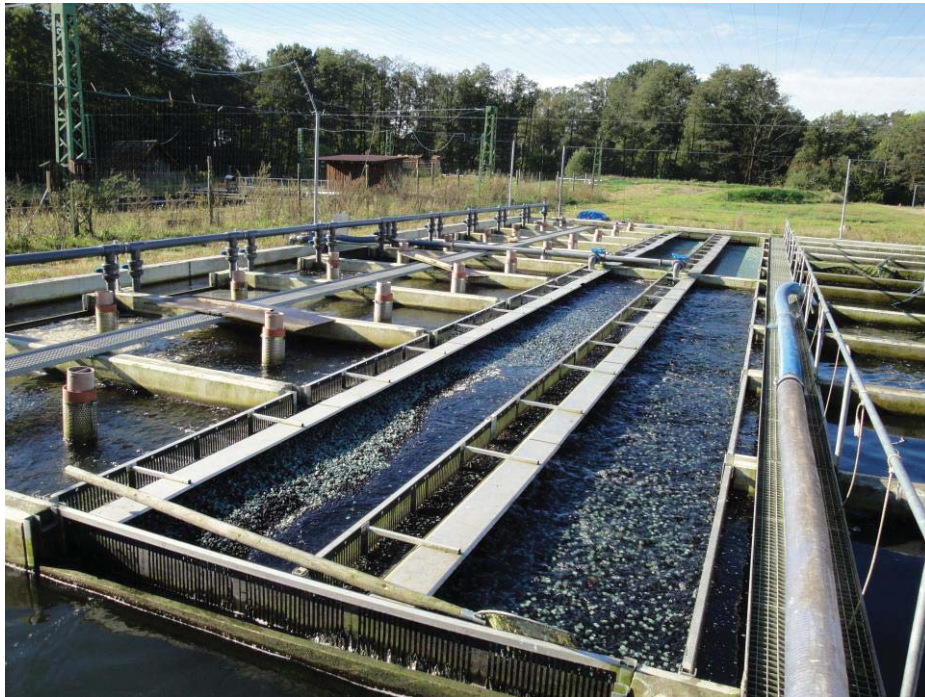
Abbildung 1: Rinnenanlage als anthropogenes Wassersystem zur potenziellen Erzeugung von Energie durch Wasserkraft mit reduziertem Umwelteinfluss (Forschungsprojekt NEEWa am Institut für Wasser- und Energiemanagement) Quelle: Harvey Harbach
